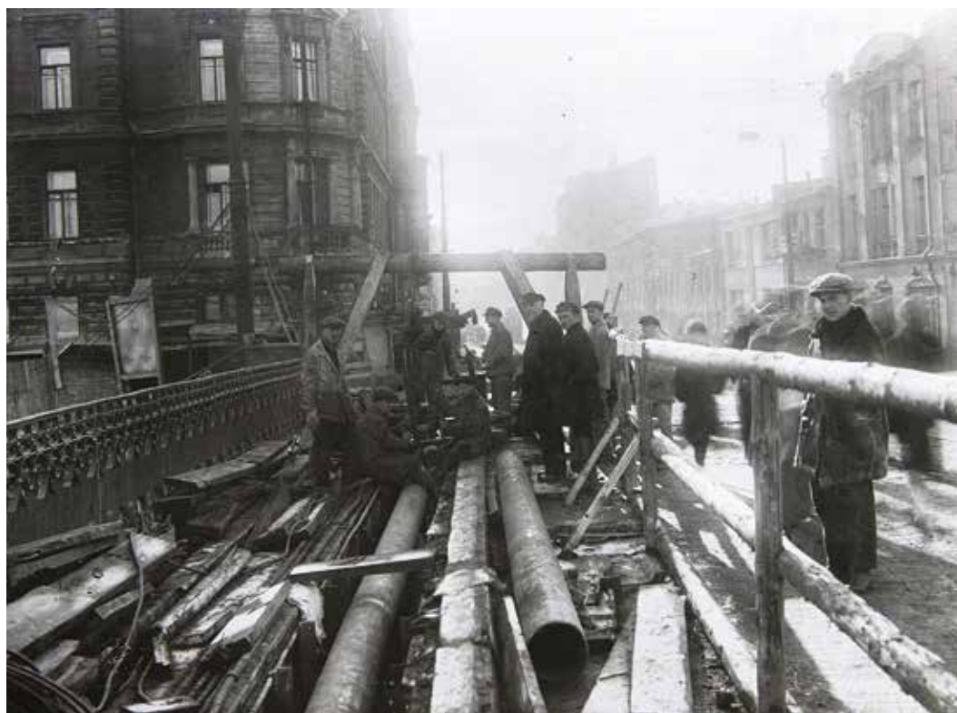
Монтаж концевого участка тепломагистрали на Малом Москворецком мосту. 1930 год
