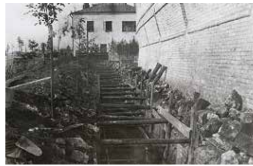
Прокладка теплопроводов у Китайгородской стены. 1930 год
