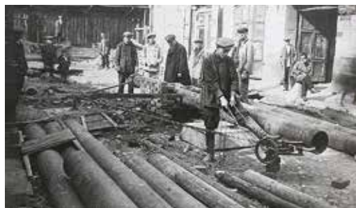
Гнутье труб на месте монтажа в Елецком переулке. 1930 год
