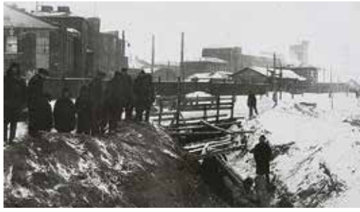
Прокладка труб по улицам столицы
