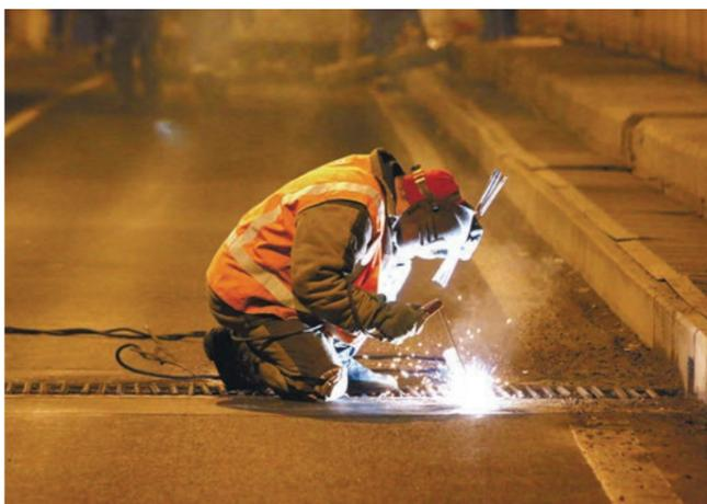
Трубы, проложенные поперёк дорожного полотна, – самые уязвимые, объясняет Сергей Панкратьев. Помимо грунтовых вод на них негативно влияют активные противогололёдные реагенты, переносимые колёсами автомобилей. После замены труб тут ведётся сварка усиливающей арматуры, которая тоже быстро изнашивается
