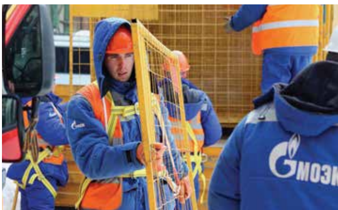
Установка ограждений места «происшествия» – обязательный элемент работы аварийной бригады
