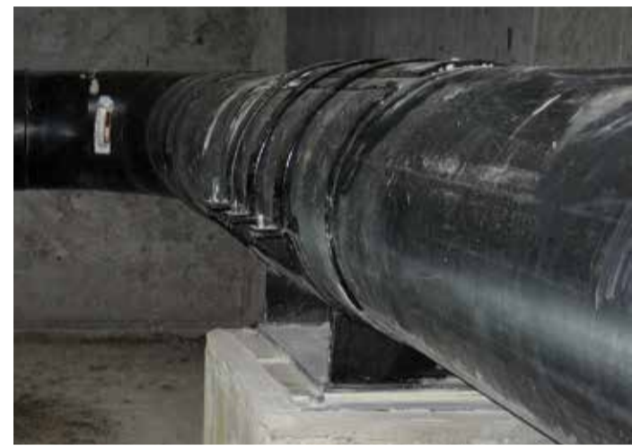
Опора готова к испытаниям – июнь 2018
