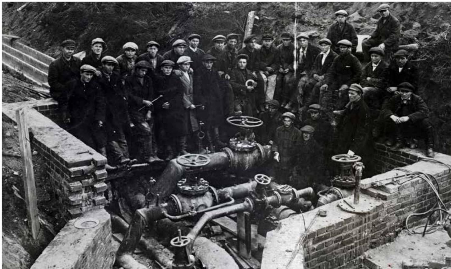
Монтаж паропровода к ГПЗ. Установка арматуры в камере отвлечения к ГПЗ. 1931 год
