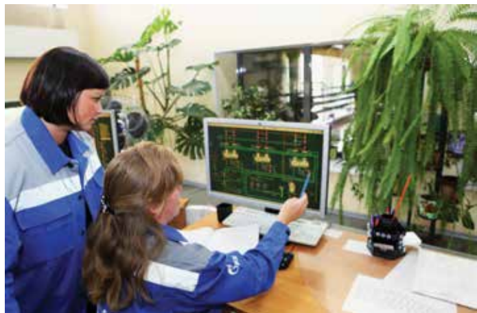
РТС «Строгино»: данные экомониторинга в автоматическом режиме передаются на пульт управления станции и в городскую систему. На фото – заместитель начальника отдела экологии и охраны окружающей среды Ольга Матюхина и начальник смены РТС Ирина Жарко
