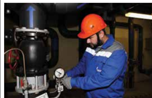
Плано-предупредительные ремонты прошли на всех находящихся в эксплуатации «МОЭК» районных и квартальных тепловых станциях (с учетом ТиНАО – 51 станция), 101 малой котельной и более 10 тыс. тепловых пунктов
