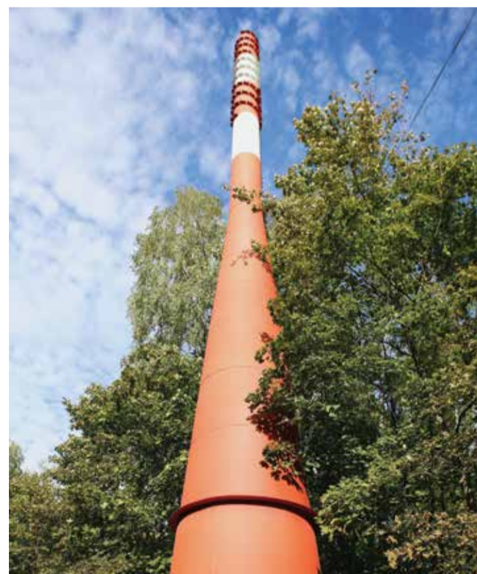
КТС-40 (предприятие №2 Филиала №4) расположена непосредственно на территории парка «Сокольники»
