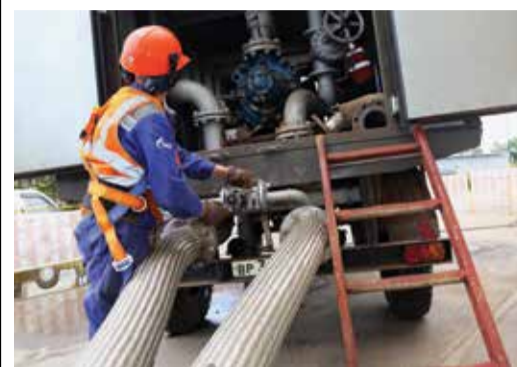
При подготовке к отопительному сезону проведены гидравлические испытания на всех тепловых сетях «МОЭК»
