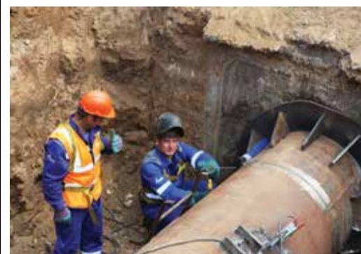
К работе в осенне-зимнем периоде подготовлено около 16,2 тыс. км тепловых сетей, в том числе порядка 8 тыс. км магистральных сетей и 8,24 тыс. км разводящих сетей
