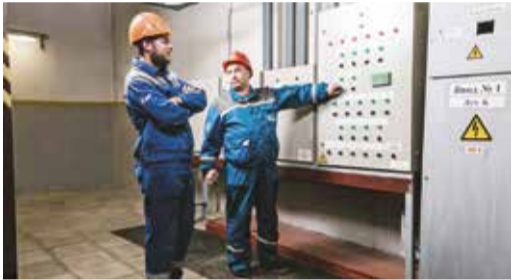
Электрооборудование теплового пункта под постоянным контролем специалистов. На фото – Дмитрий Гуркин и Роман Галкин
