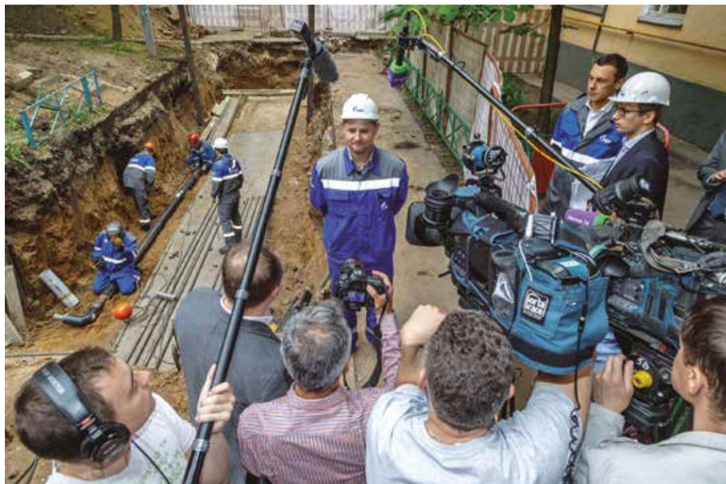
Наконец, третья точка на нашем маршруте — ремонтные работы по замене участка трубопровода по адресу: ул. Студенческая, д. 12. Здесь проводится замена старых труб теплового ввода. О процессе и преимуществах труб в ППУ-изоляции рассказывает заместитель главного инженера Филиала № 1 по магистральным тепловым сетям Рустам Курашин
