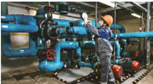
Ревизия манометра узла ХВС. На фото – Сергей Волченков
