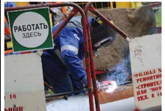
Сотрудники ремонтных бригад «МОЭК» произвели условное вскрытие трубопровода и устранили течь
