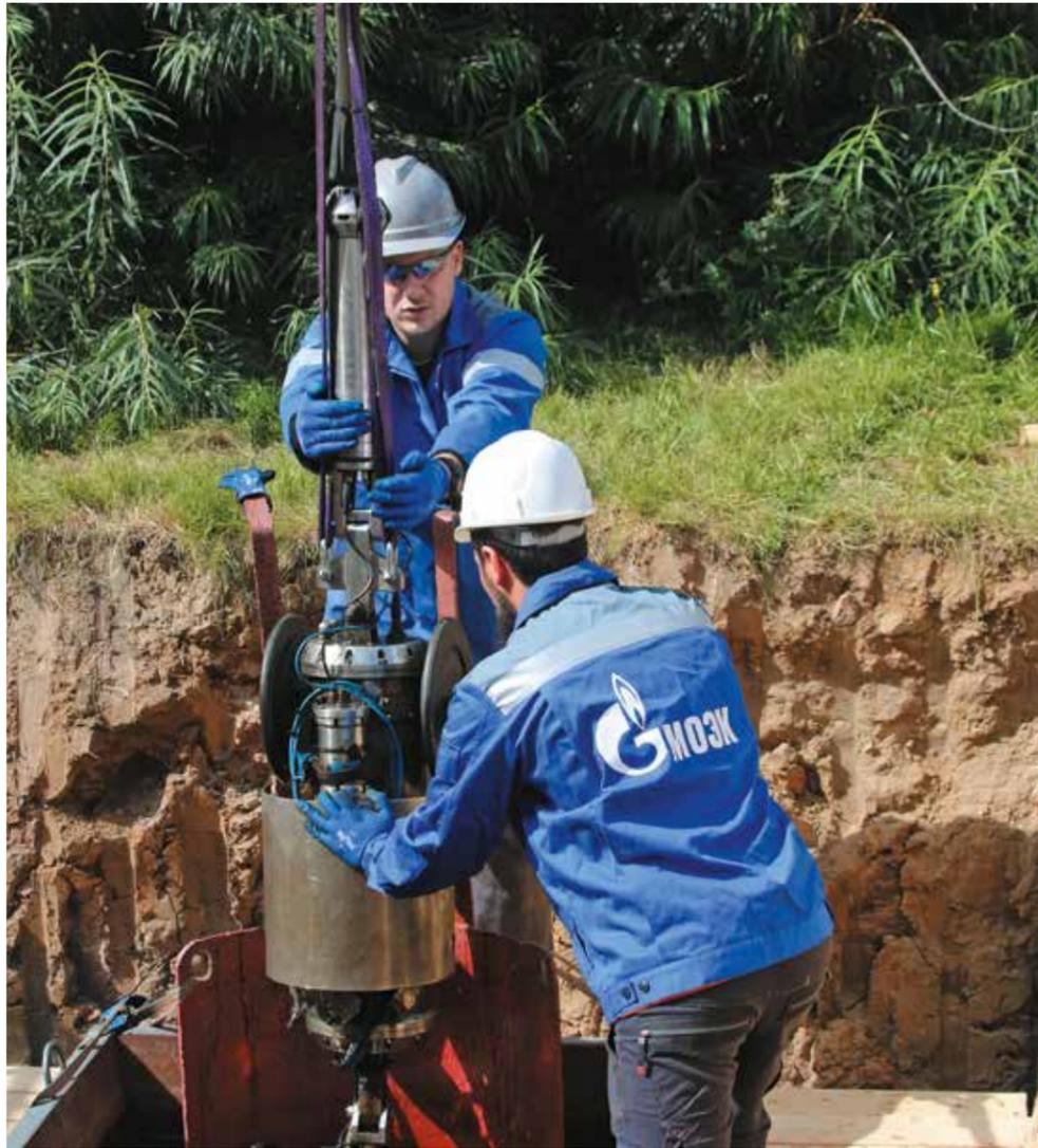
Запуск внутритрубного дефектоскопа сплошного ультразвукового сканирования импульсным методом
