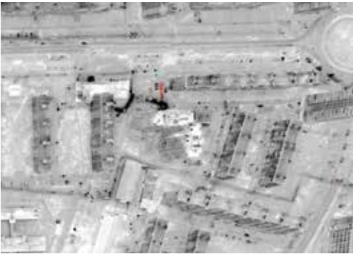
После ночного полёта: это же место в инфракрасном режиме. Тёмные пятна (более «тёплые» объекты) – потенциальные проблемные места (возможна утечка теплоносителя, повреждение изоляции и т. д.), требующие дополнительной проверки ремонтными службами ПАО «МОЭК»
