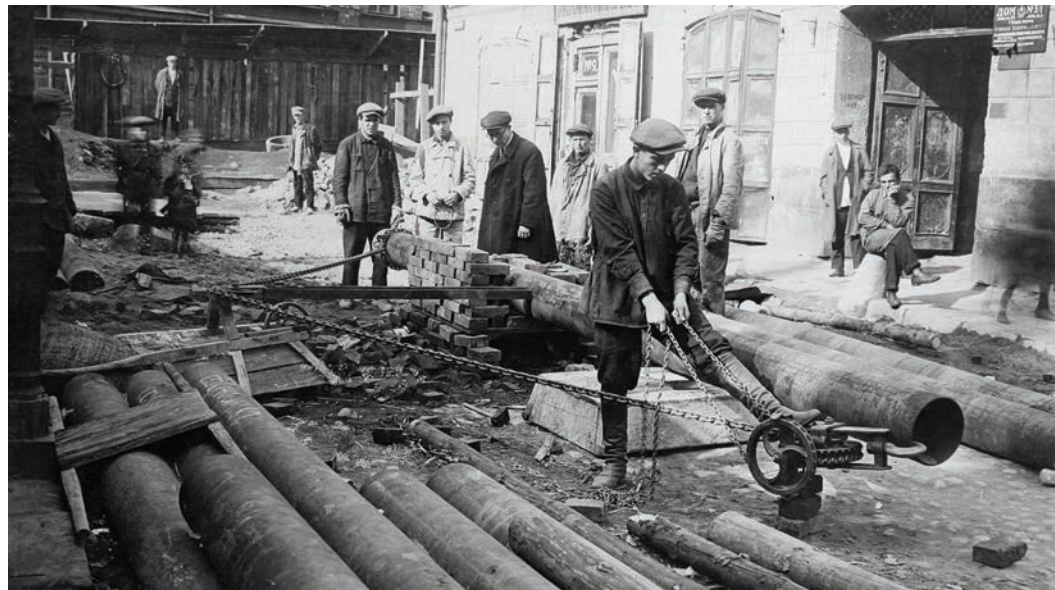
Монтаж тепломатрицы в Елецком переулке. 1930 год
