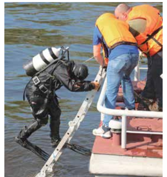
Водолазы провели условные работы по установке гидроромбы
