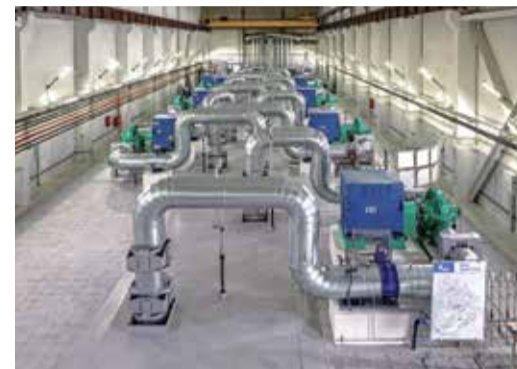
Оборудование станции полностью обновлено
