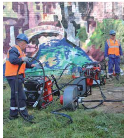
Сотрудники «ТСК Мосэнерго» развернули оборудование и средства малой механизации
