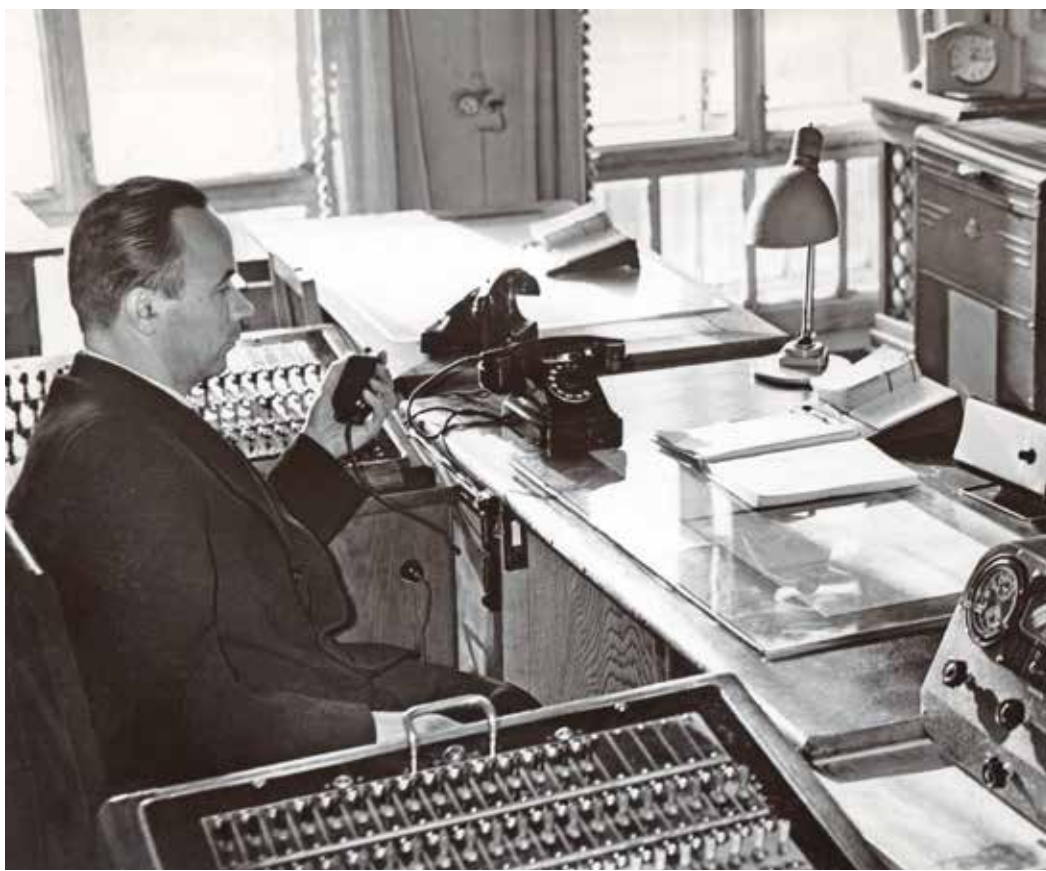
Центральный диспетчерский пункт теплосети «Мосэнерго»; фото из архива Музея «Мосэнерго» и энергетики Москвы
