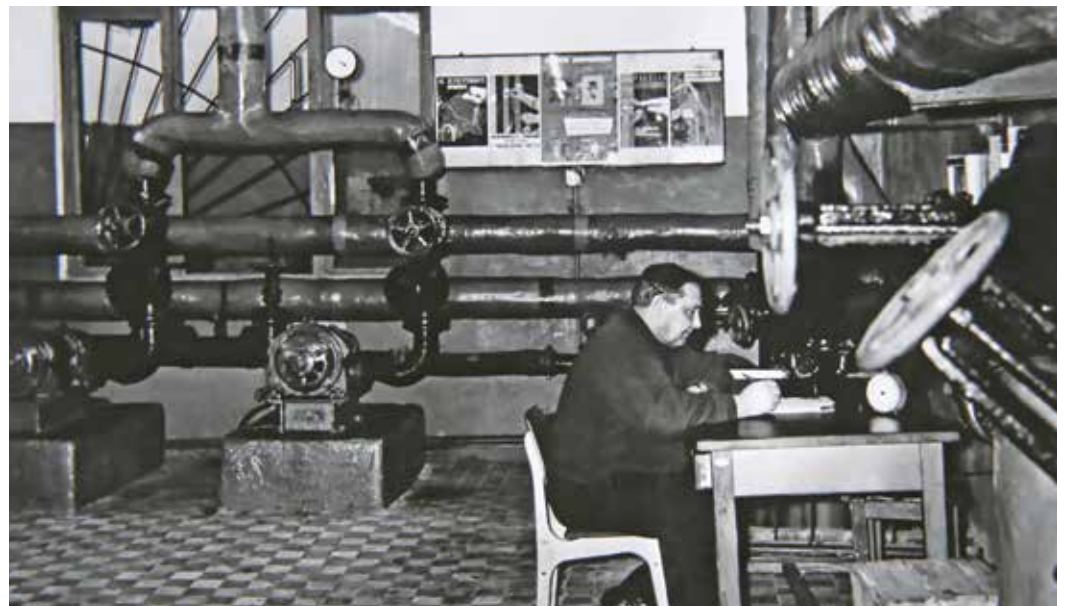
ЦТП Беляево Богородское 8 район Теплосети
