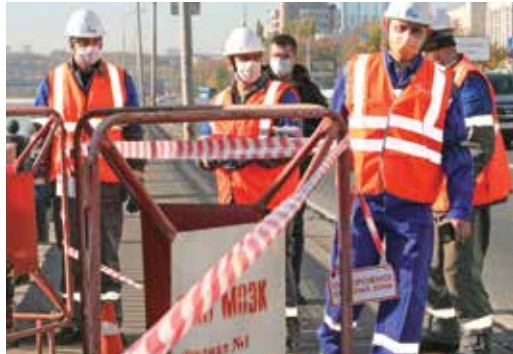
Ограждение места работ и выставление наблюдающего — обязательное условие
