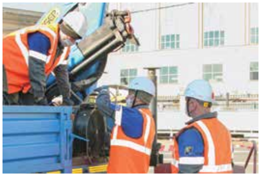
Специалисты обеспечивают вентиляцию камеры
