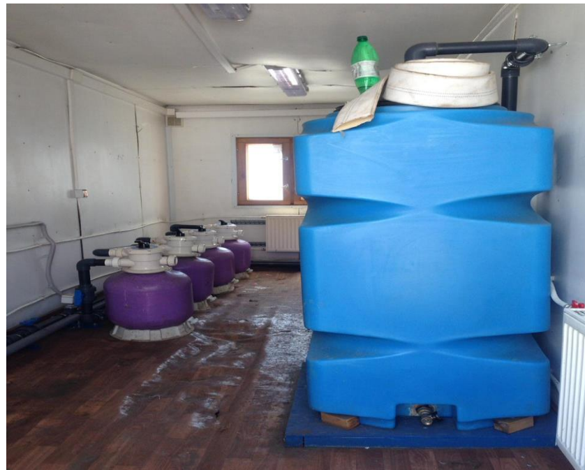
Очистные сооружения производственной площадки ПАО «МОЭК»
