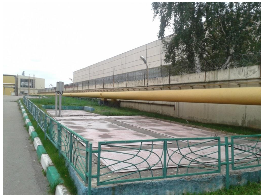
Очистные сооружения РТС «Строгино» ПАО «МОЭК»
