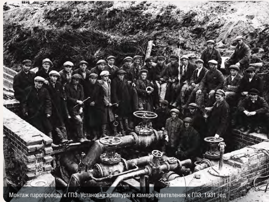
Монтаж паропровода к ГПЗ. Установка арматуры в камере ответвления к ГПЗ, 1931 год
